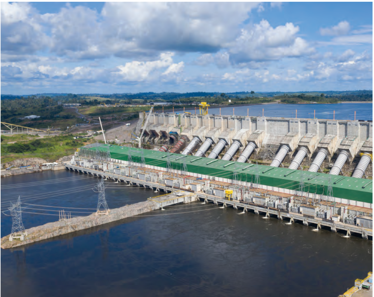
Casa de Força Principal. Roney Santana
