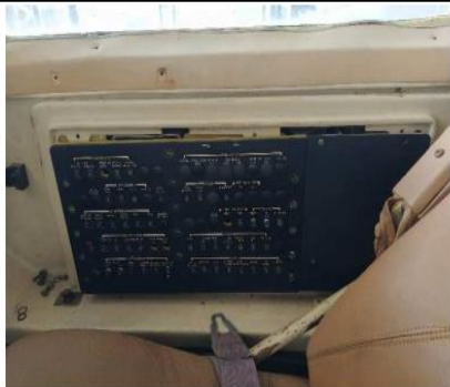
PT-SCE - PAINEL DE DISJUNTORES LADO DIREITO
