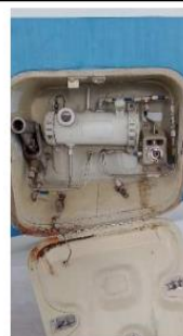
PT-SCE - SISTEMA HIDRÁULICO DA PORTA DE CARGA
